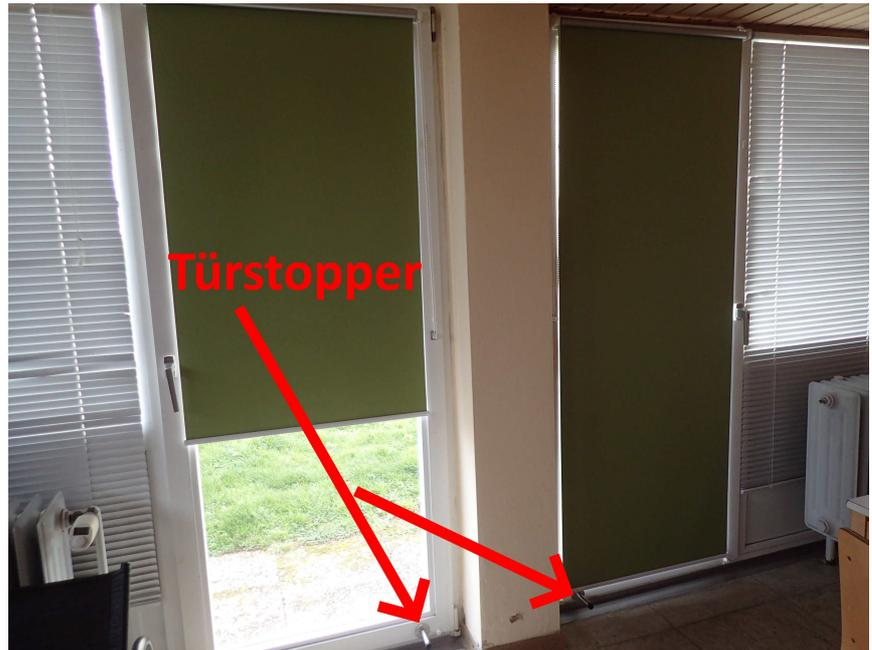
Spezial-Firma erschien uns sehr teuer. Daher haben wir uns für den Einbau in Eigenleistung entschieden, und brauchten dafür nur 13 % der sonst entstandenen Kosten. Zusätzlich haben wir Türstopper angebracht, weil deren Fehlen die Ursache für die Zerstörung der alten Rollos waren. Dadurch, und das wird auffallen, lassen sich die Türen nicht mehr ganz so weit öffnen. Aber das ist das kleinere Übel, als bald wieder defekte Rollos, und dadurch Fortschreiten der Boden-Unebenheiten.
